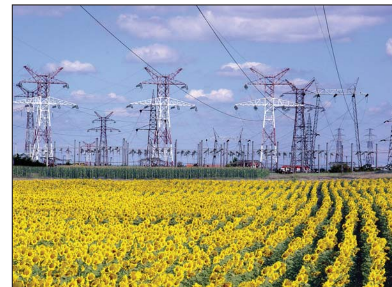
Grade se nove i obnavljaju postojeće transformatorske stanice: Elektroenergetska mreža Srbije
